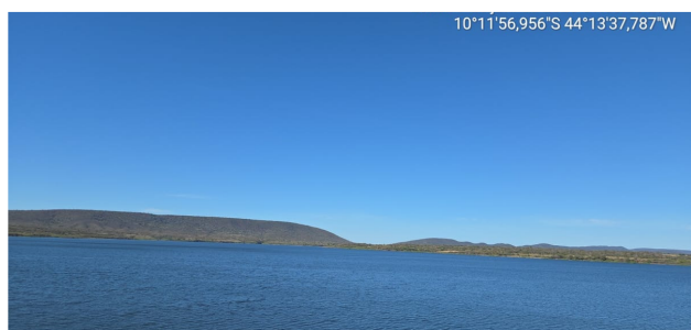
Vista do Barramento
