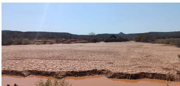
Vista do Barramento
