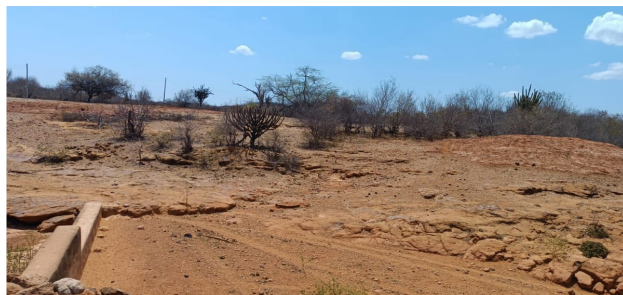
Vertedouro ou Sangradouro
