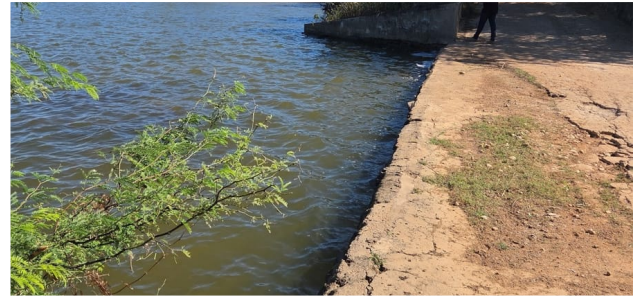
Vertedouro ou Sangradouro
