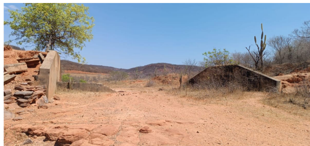
Vertedouro ou Sangradouro
