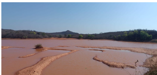
Vista do Barramento
