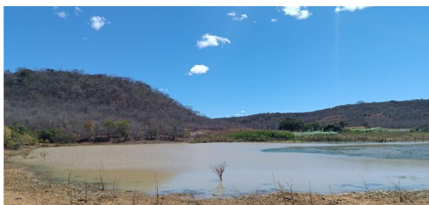
Vista do Barramento
