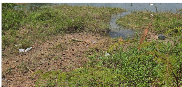
Vista do Barramento
