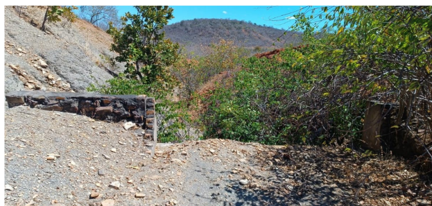
Vertedouro ou Sangradouro
