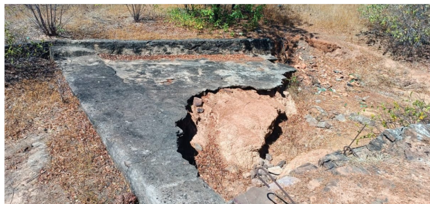
Vertedouro ou Sangradouro
