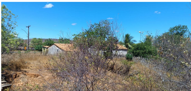
Residência nas proximidades do sangradouro
