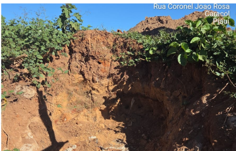
Bueiro que liga as duas partes do açude
