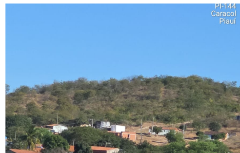
Construções próximas do Açude
