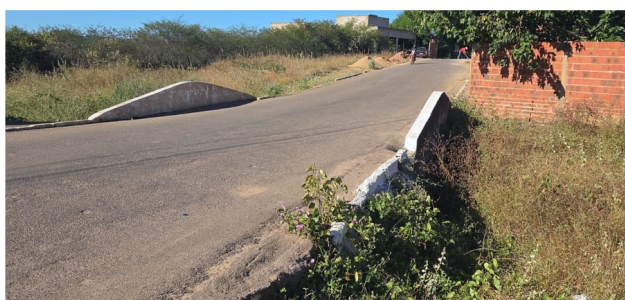
Vertedouro ou Sangradouro
